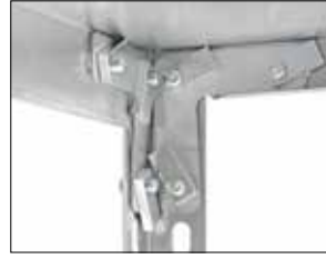
Eckplatten sorgen für Stabilität
